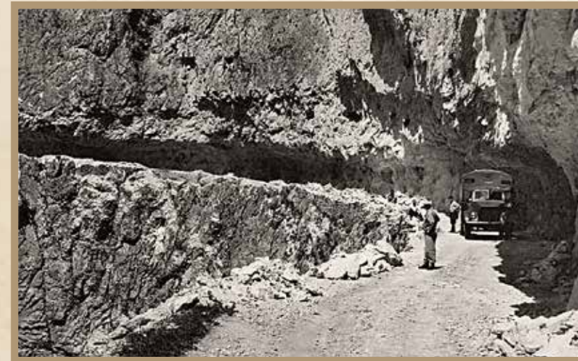
♣ Зылгы-Тар. Часть дороги после расширения для проезда автомобилей
