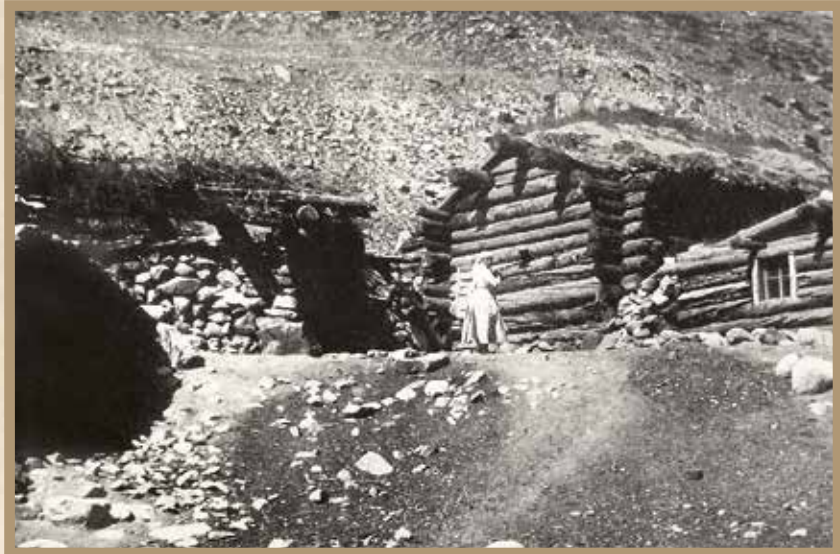
✦ Баксанское ущелье, вторая половина XIX века. Старый деревянный дом. Кровля засыпана землёй. Такое покрытие оберегало от камнепада. Дом из сосновых брёвен был прочный, тёплый и долговечный. Вторая половина XIX века
