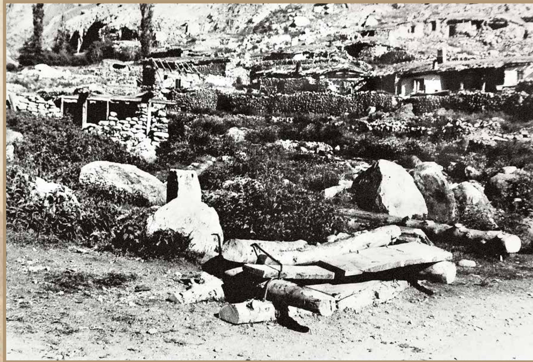
◆ Дорласын — приспособление для перевозки больших каменных глыб. Селение Верхний Чегем
