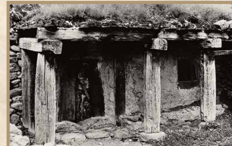
Старая сакля. В деревянных колоннах мы видим ребра жёсткости. Иногда в колоннах были до 16 ребер жёсткости. Балкарцы такие колонны применяли в строительстве издревле. Такие дома стояли 300–400 лет
