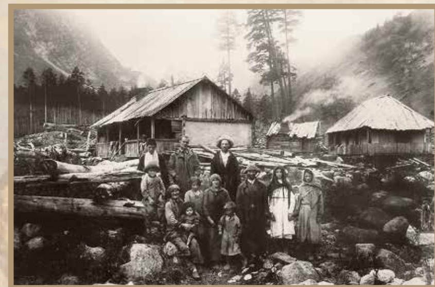
Старый Тегенекли. Очищая землю от камней, готовили площадки для строительства домов и огородов. Начало XX века
